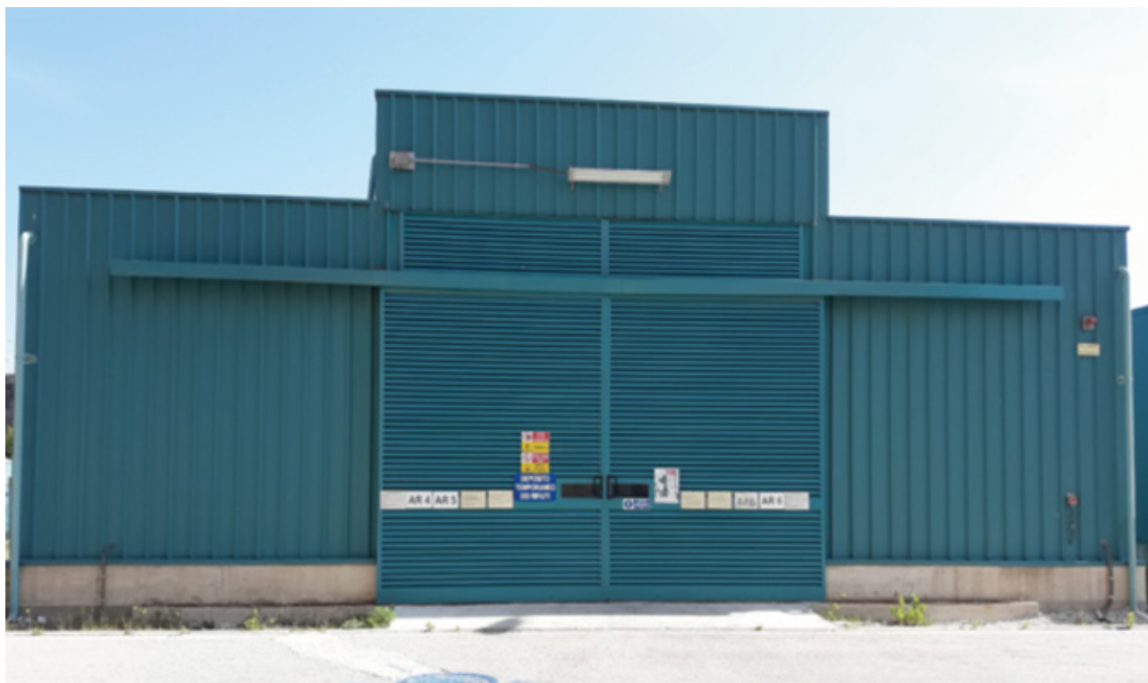
Figura 14b: Deposito temporaneo rifiuti non pericolosi
