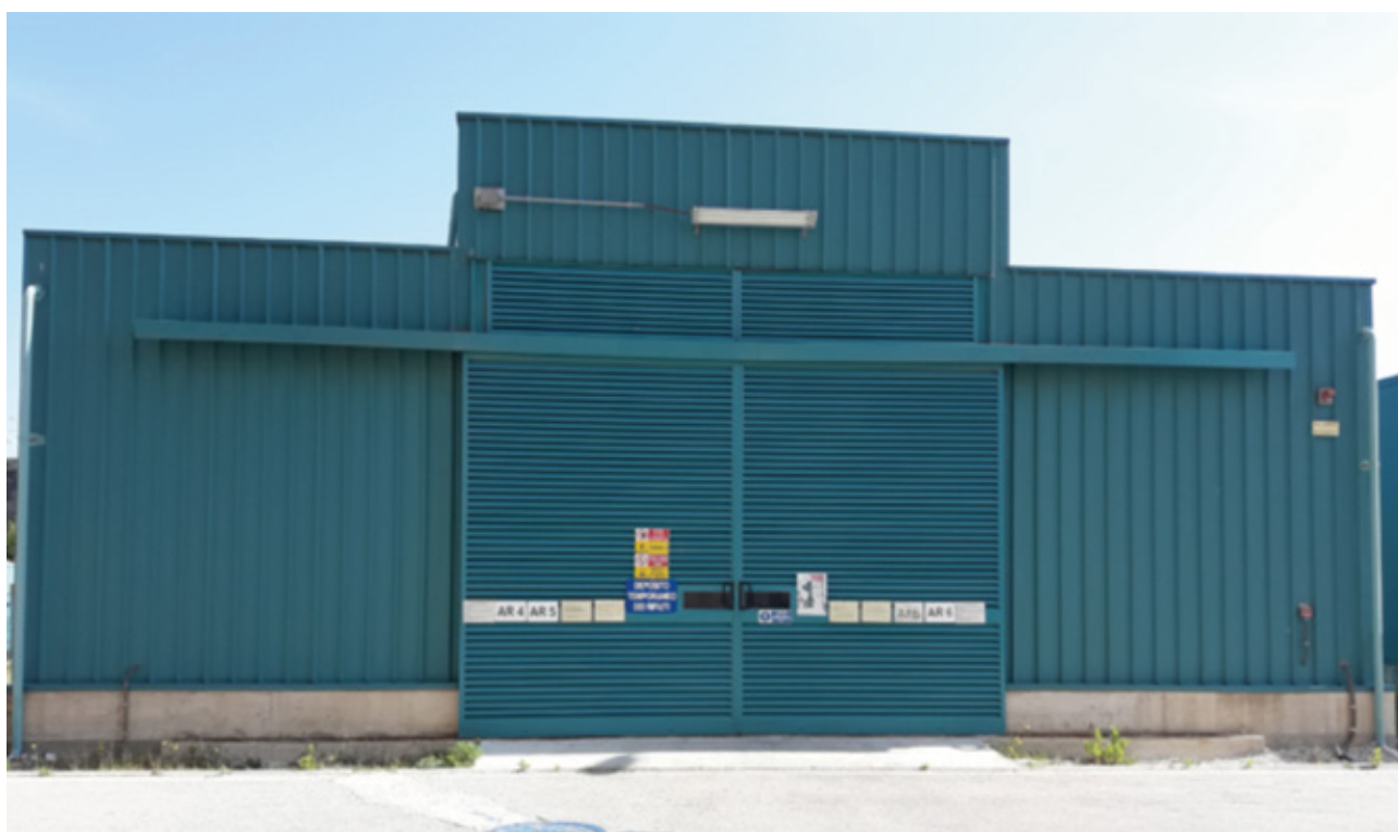
Figura 14b: Deposito temporaneo rifiuti non pericolosi
