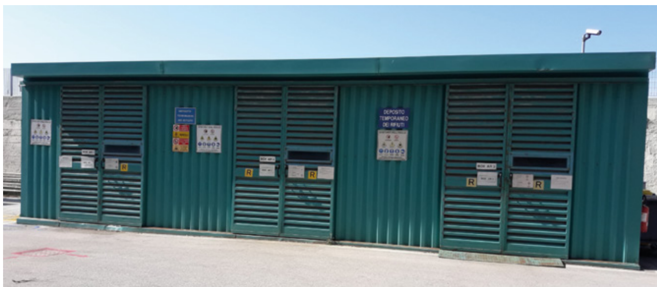
Figura 14a: Deposito temporaneo rifiuti pericolosi
