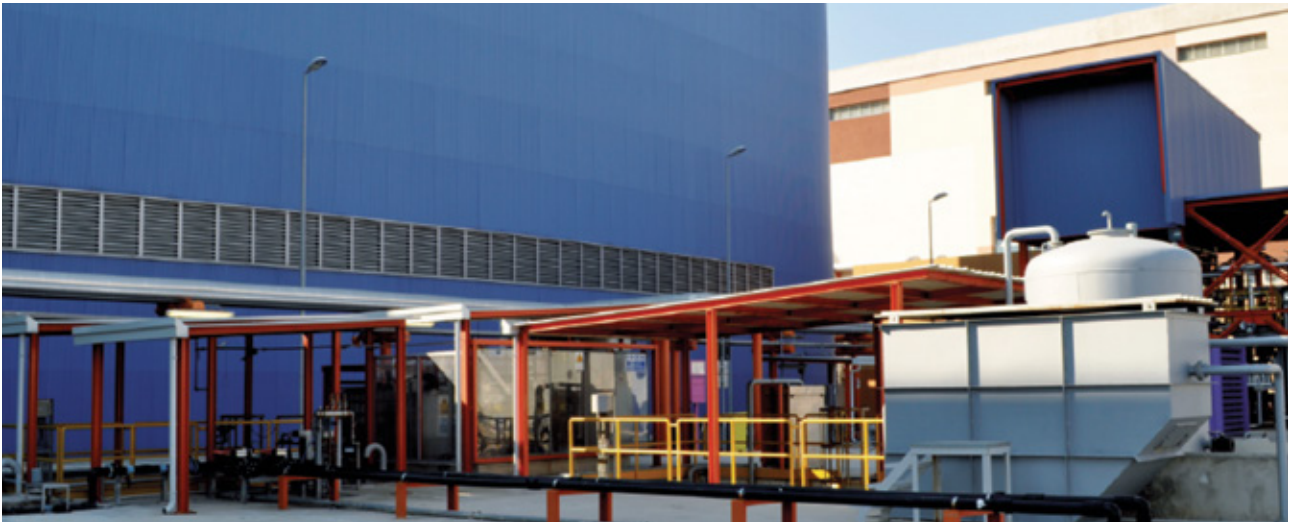
Figura 13: Impianto di Trattamento delle Acque Reflue
