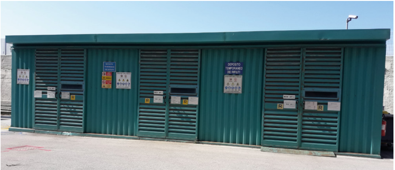
Figura 15: Deposito temporaneo rifiuti pericolosi
