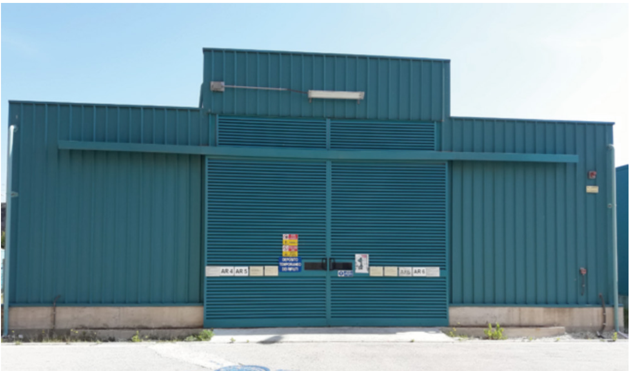
Figura 16: Deposito temporaneo rifiuti non pericolosi
